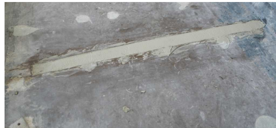
Eindresultaat (voor aanbrengen afwerking)
