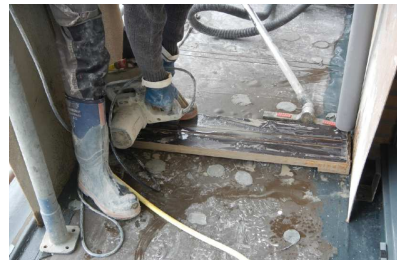
Aanbrengen zaagsneden sleuven
