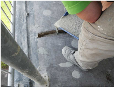
Aangieten sleuf met mortel
