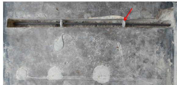
Wapening met afstandhouders in sleuf
