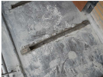
Situatie na open hakken sleuf
